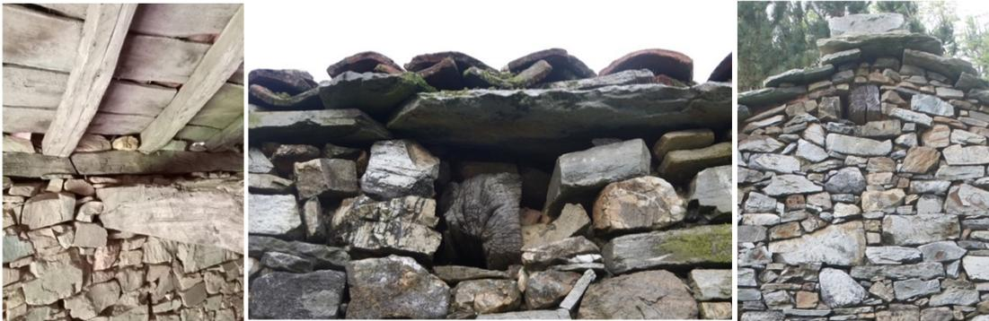
Figuras 36, 37 y 38 (de izq. a der.): Tirante central interior y exterior (fachada este) y cumbrera (fachada norte).
