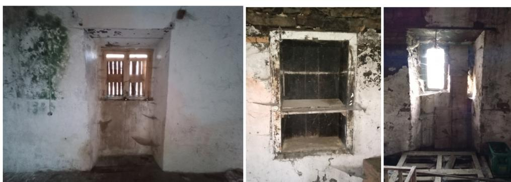
*Figuras 64, 65 y 66 (de izq. a der.): Patologías derivadas de los altos niveles de humedad y el desuso.*
